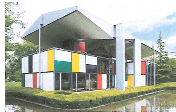
Pavillon Le Corbusier, Zürich
